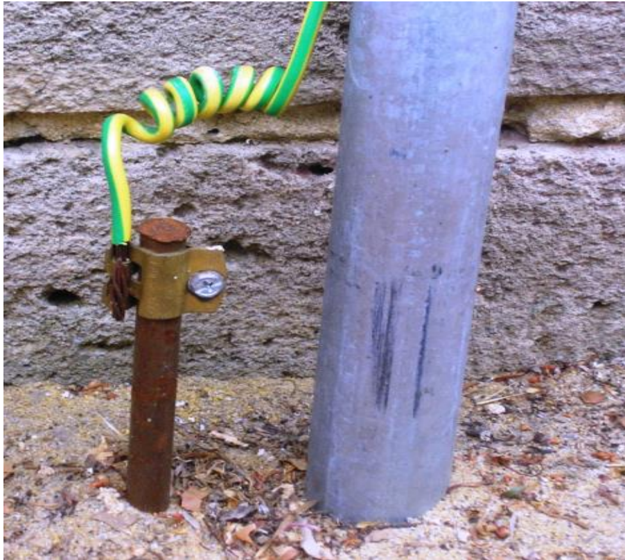
Fig. 3.44 Rod Earthing
