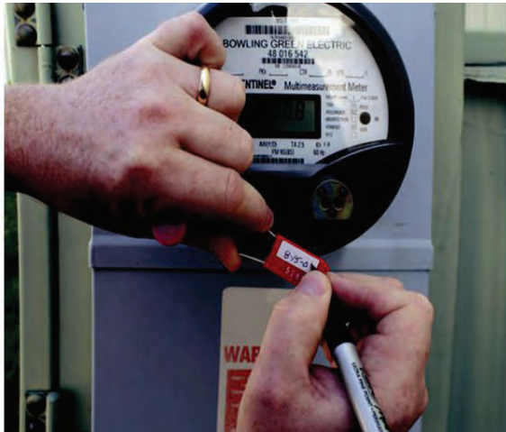
Fig. 4.20 Sealing meter
